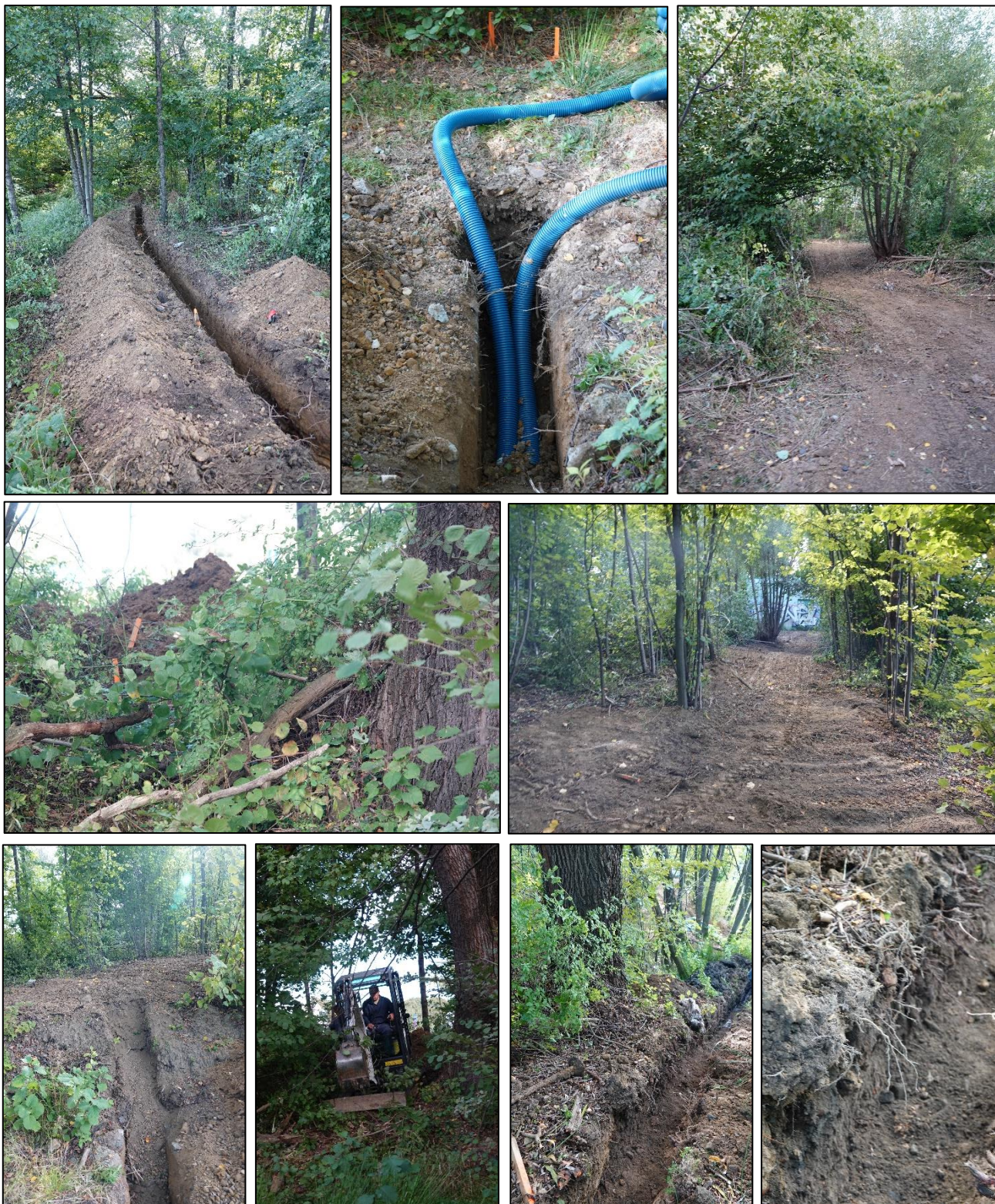
Fot. 1-9. Zdjęcia przedstawiające realizację prac ziemnych przy użyciu minikoparki oraz częściowo teren wykopu w trakcie i po zasypaniu.
