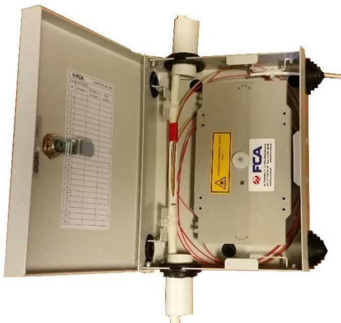
Fotografia mufy z kasetą światłowodową
