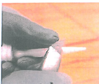
Przycinanie dyszy w zależności od wymiaru szczeliny
