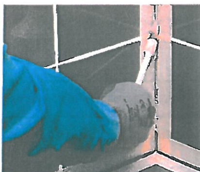
Gruntowanie boków szczeliny przy użyciu Primer EF
