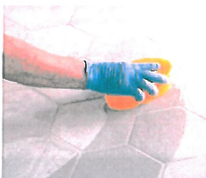
Czyszczenie i profilowanie spoin twardą celulozową gąbką
