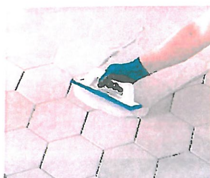
Rozprowadzanie Keracolor FF za pomocą pacy MAPEI
