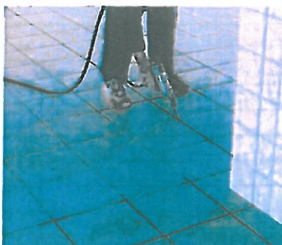
Spoinowanie posadzki za pomocą pistoletu pneumatycznego
