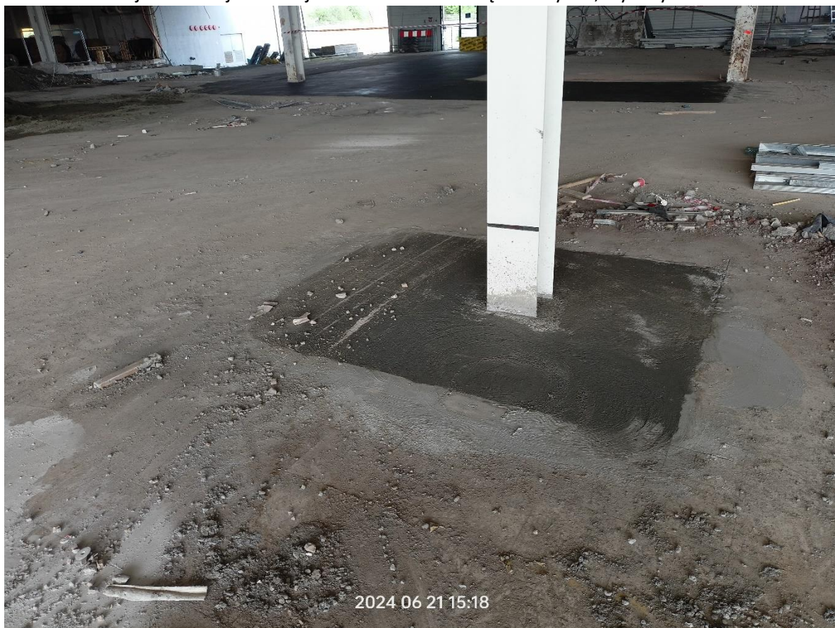
6 Montaż nowej konstrukcji stalowej w osi C3 oraz wewnątrz budynku, wykonywanie zalewek
