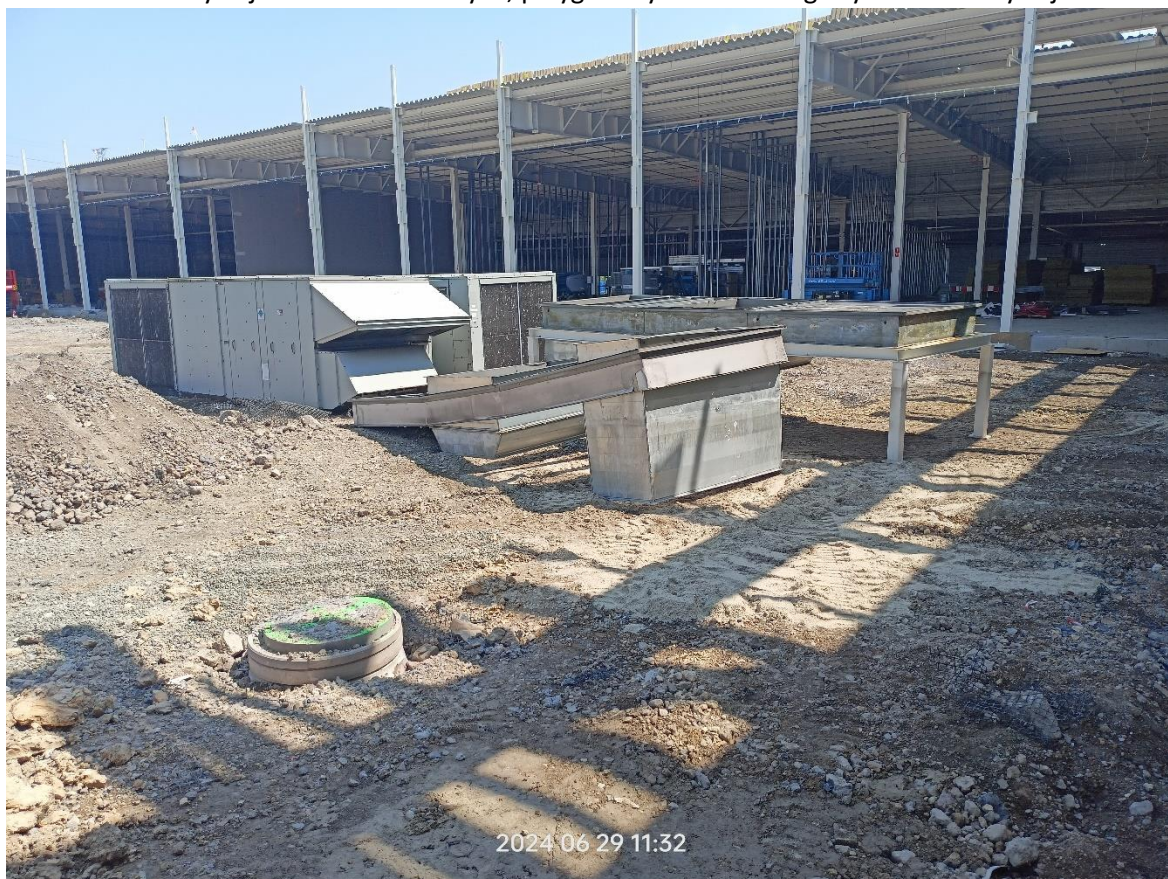
6 Demontaż starych jednostek dachowych, przygotowywanie nowego systemu wentylacji
