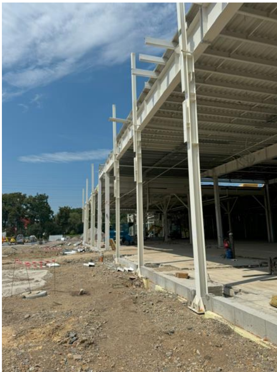
4.Montaż trzpieni na BurgerKing
