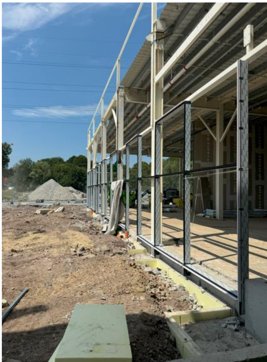
3.Montaż dalszej części konstrukcji stalowej w osi C3' oraz osi 5
