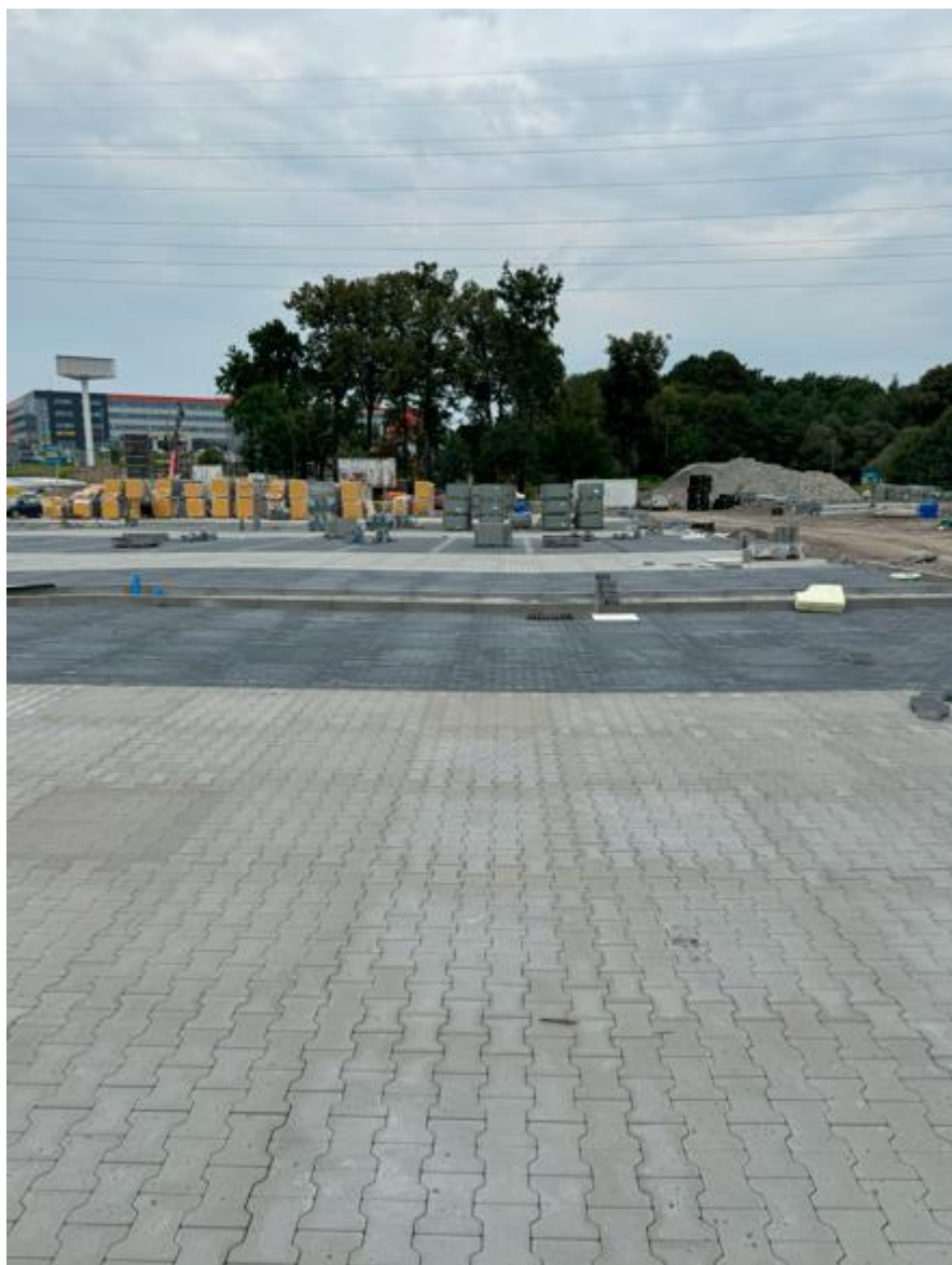
6. Betonowanie trzpieni na ścianie w osi K'
