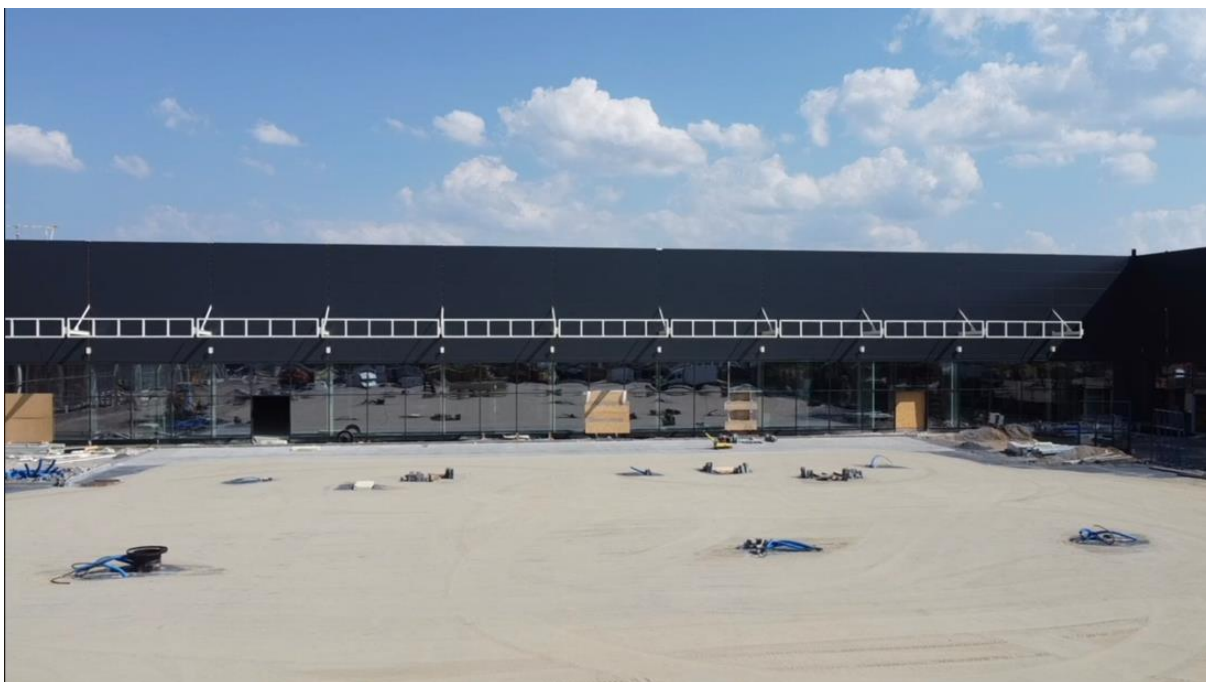
2 Wykonywane są prace na dachu w postaci doszczelnień konstrukcji stalowych oraz montażu instalacji na dachu
