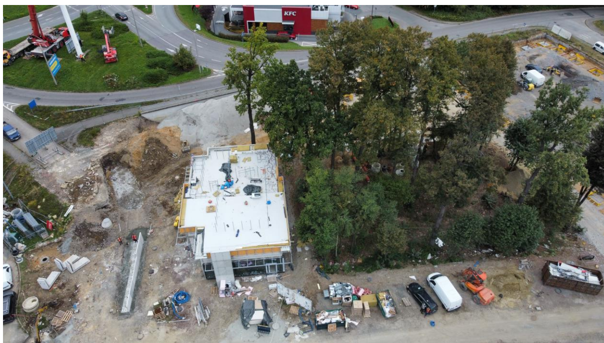
5. Dach lokalu Burger King, montaż muru oporowego wzdłuż Drive-thru
