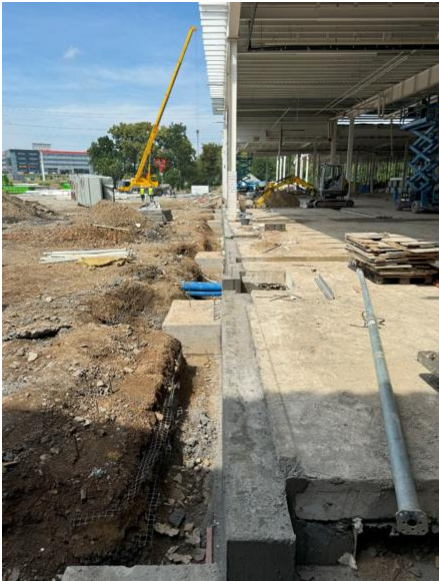
6. Dalszy demontaż konstrukcji stalowej
